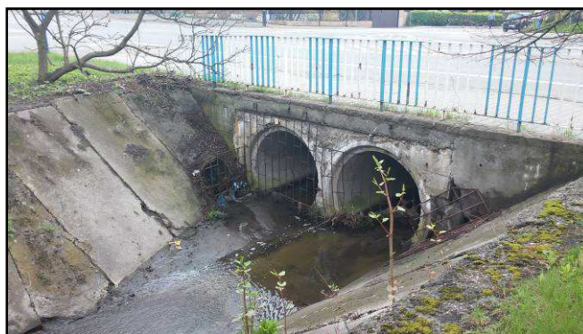
Rys. 5.1 Potok Bycznka przepływający przez analizowany teren
